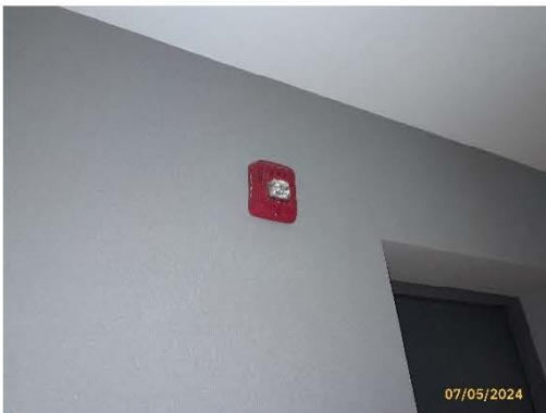
อุปกรณ์ส่งเสียงสัญญาณแบบกระดิ่งสัญญาณ
