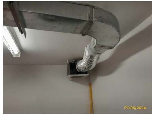
ท่อ/พัดลมดูดอากาศห้องพักมูลฝอยเปียก
