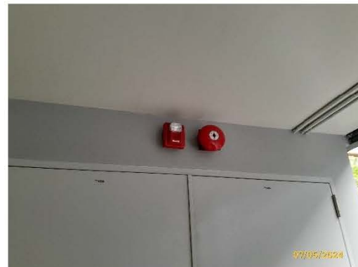
อุปกรณ์ส่งเสียงสัญญาณแบบกระดิ่งสัญญาณ
