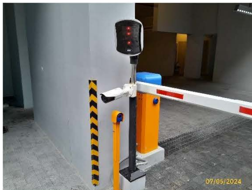
ระบบอิเล็กทรอนิกส์สำหรับควบคุมการเข้า-ออก
