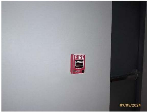
อุปกรณ์ส่งสัญญาณอัคคีภัยแจ้งเหตุด้วยมือ
